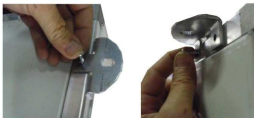
Obr. 1 – Instalace upevňovacích držáků na jednotku
